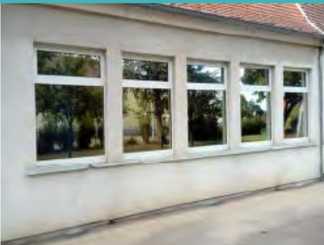
Le film **ECLYPSE 80VP** ionisé miroir permet de voir sans être vu. Il protège des regards extérieurs tout en assurant une parfaite visibilité de l'intérieur vers l'extérieur. Souvent utilisé pour la protection des écoles et lieux sensibles dans le cadre du plan Vigipirate. C'est également un film anti-chaueur qui filtre fortement les InfraRouges et permet une bonne réduction des éblouissements.
